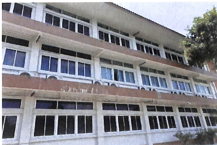
รูปที่ 4.14 แผงบังแดดคอนกรีตภายนอกของอาคารสำนักงานเขตพื้นที่การศึกษาประถมศึกษา ปทุมธานี เขต 1
