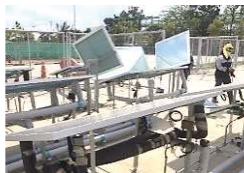
รูปที่3. การติดตั้งอุปกรณ์เพิ่มความเข้มแสง
