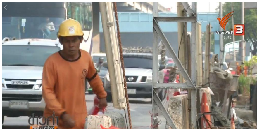
ภาพประกอบที่ 2.4: ภาพแสดงถึงพื้นที่ก่อสร้างได้รับผลกระทบจากฝุ่นละออง PM 2.5 ที่มา: รายการพลิกปมข่าวออกอากาศ วันที่ 14 ก.พ. 61
