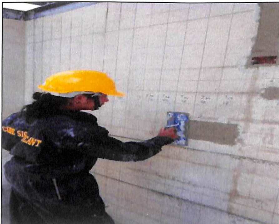
ภาพแสดงการทิ้งปูนให้หมาด และทำการปั้นหน้าปูนด้วยเกรียง เพื่อให้ปูนได้ผิวหน้าที่แข็งแรงและเรียบเสมอนั่งเดิม
