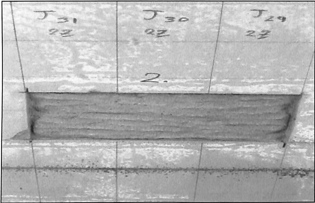
ภาพแสดงการใส่ปูนไปในพื้นที่ที่ทำการซ่อมแซม
