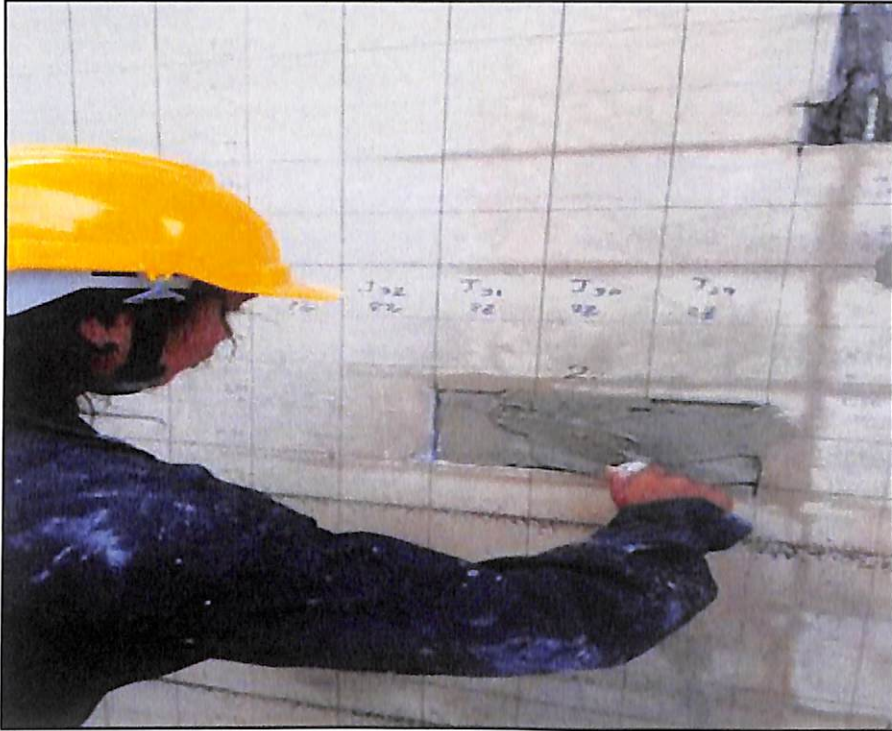
ภาพแสดงการนำปูนมาปิดทับตาข่ายไฟเบอร์ให้เต็มพื้นที่
