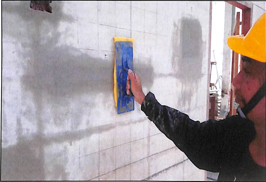
ภาพแสดงการปั่นลงฟองน้ำอีกครั้ง เพื่อให้ได้ผิวผนังที่ละเอียด สมบูรณ์ขึ้น
