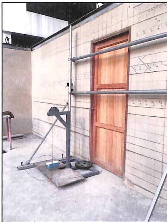
ภาพแสดงการประตู่กระทบวงกบและผนังพร้อมตรวจสอบชิ้นงาน
