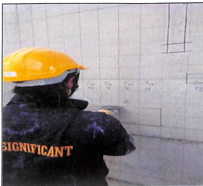
ภาพแสดงการกรีดผนังตามตำแหน่งที่กำหนดไว้โดยให้ห่างจากรอยแตกร้าวข้างละ 3 เซนติเมตร
