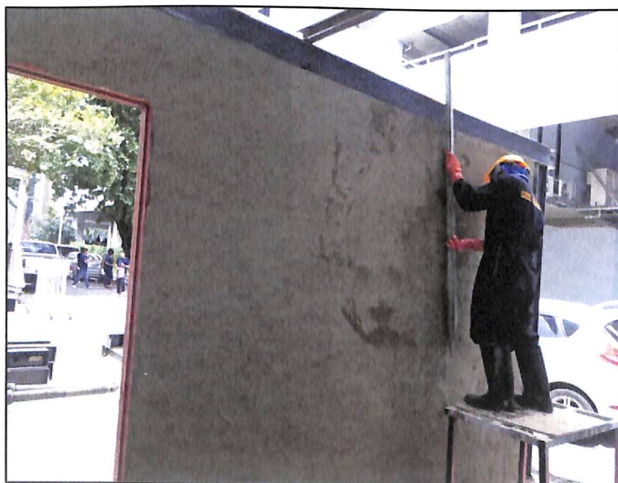
ภาพประกอบที่ 3.4 แสดงกระบวนการปาดหน้าปูนด้วยไม้สามเหลี่ยม
