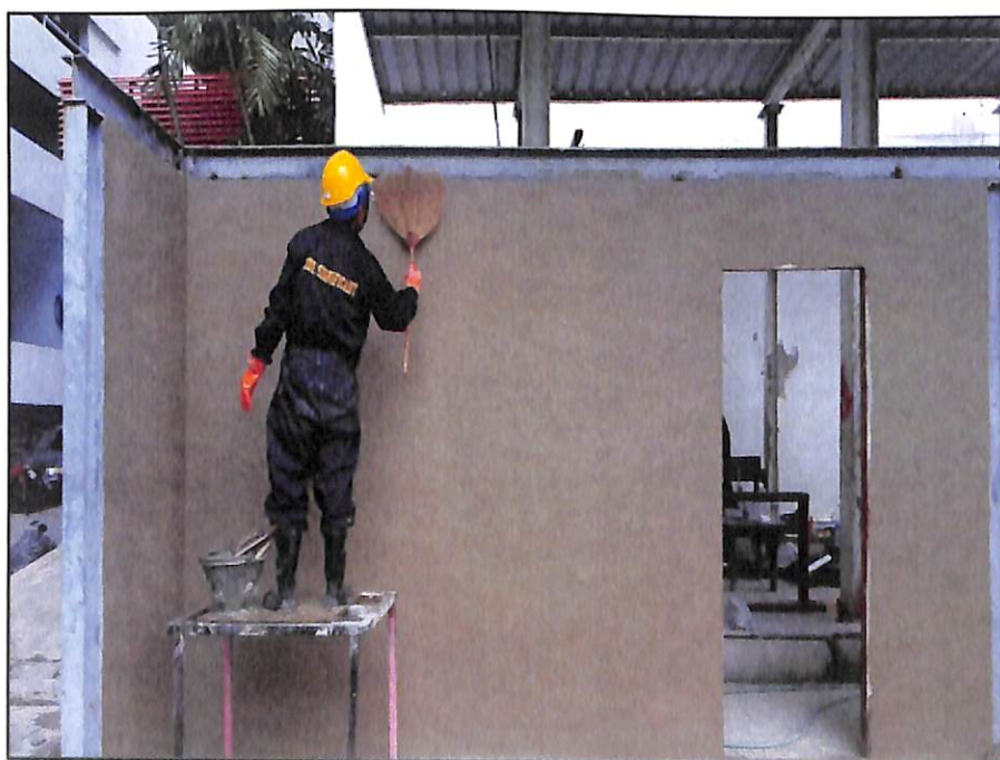
ภาพประกอบที่ 3.8 แสดงกระบวนการใช้ไม้กวาดอ่อนปิดเอาเม็ดทรายออก
