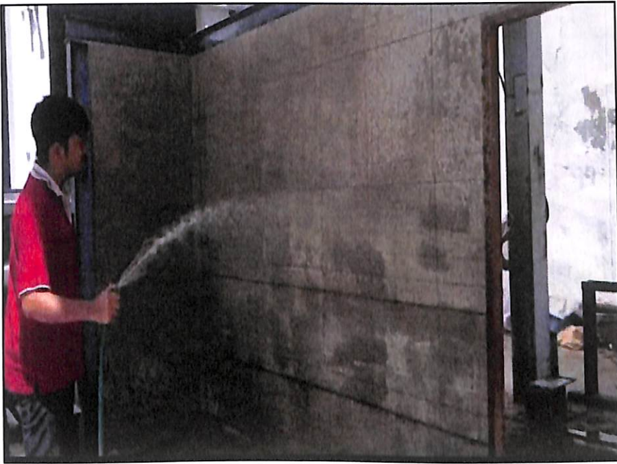
ภาพประกอบที่ 3.9 แสดงกระบวนการบ่มผนังด้วยวิธีการฉีดพรมน้ำ
