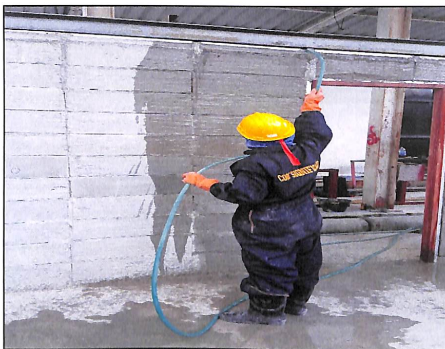
ภาพประกอบที่ 3.2 แสดงการฉีดพรมน้ำบนผนังบล็อกประสานมวลเบา
