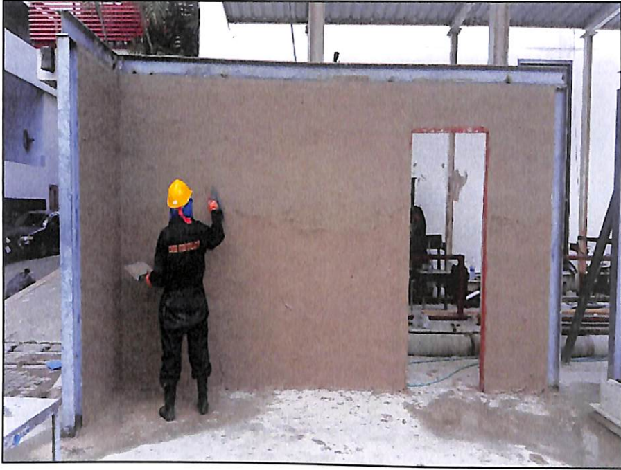
ภาพประกอบที่ 3.5 แสดงกระบวนการแต่งหน้าปูน
