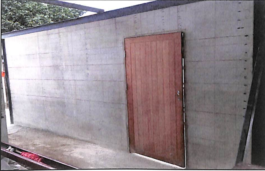
ภาพประกอบที่ 4.3 แสดงรอยแตกร้าวกลางจาบริเวณผนัง
