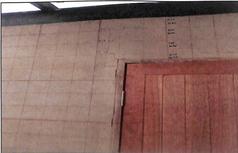
ภาพประกอบที่ 4.4 แสดงรอยแตกร้าวที่มุมวงกบ
