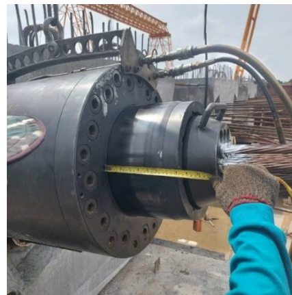
(b) การวัดระยะการเคลื่อนที่ของแม่แรง
