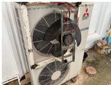
ภาพที่ 7 แสดงการเก็บประกอบโครงเหล็กและอุปกรณ์เข้ากับเครื่องระบายความร้อนของเครื่องปรับอากาศ
