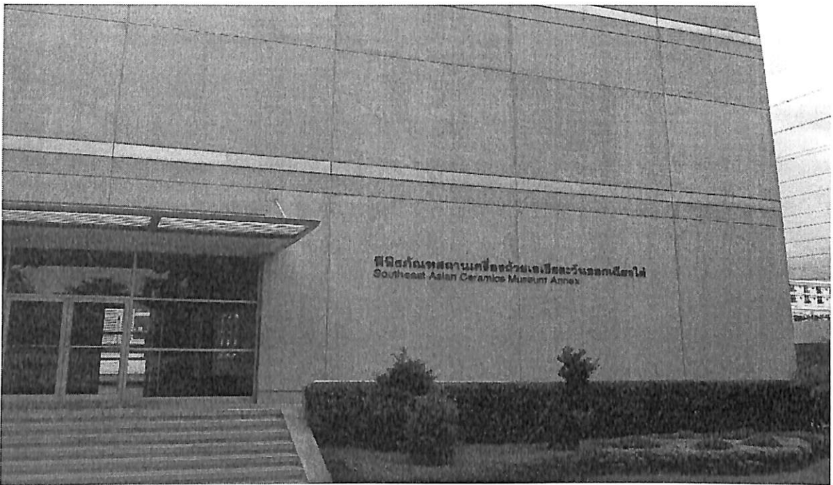
ภาพประกอบที่ 4 ผิวคอนกรีตเปลี่ยนจากการหล่อด้วยระบบ PRECAST
