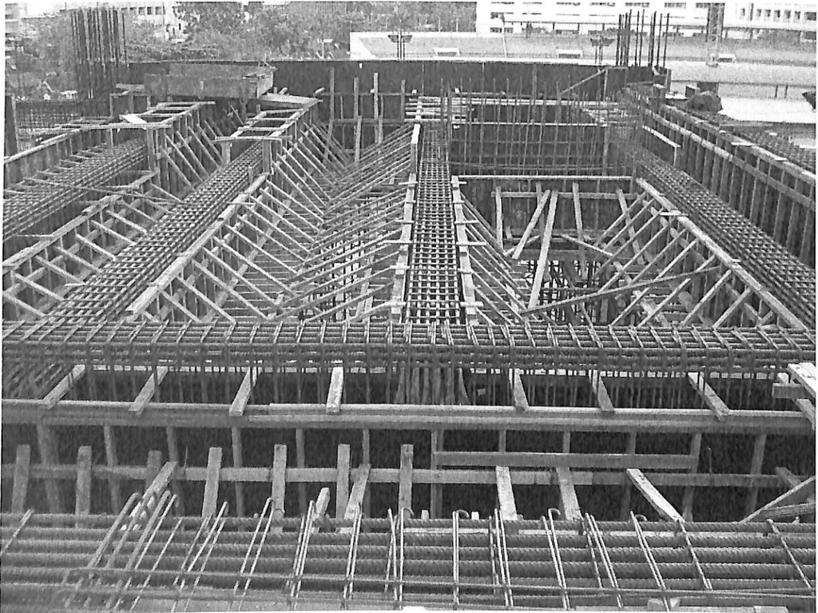
ภาพประกอบที่ 25 แบบหล่อและค้ำยัน
