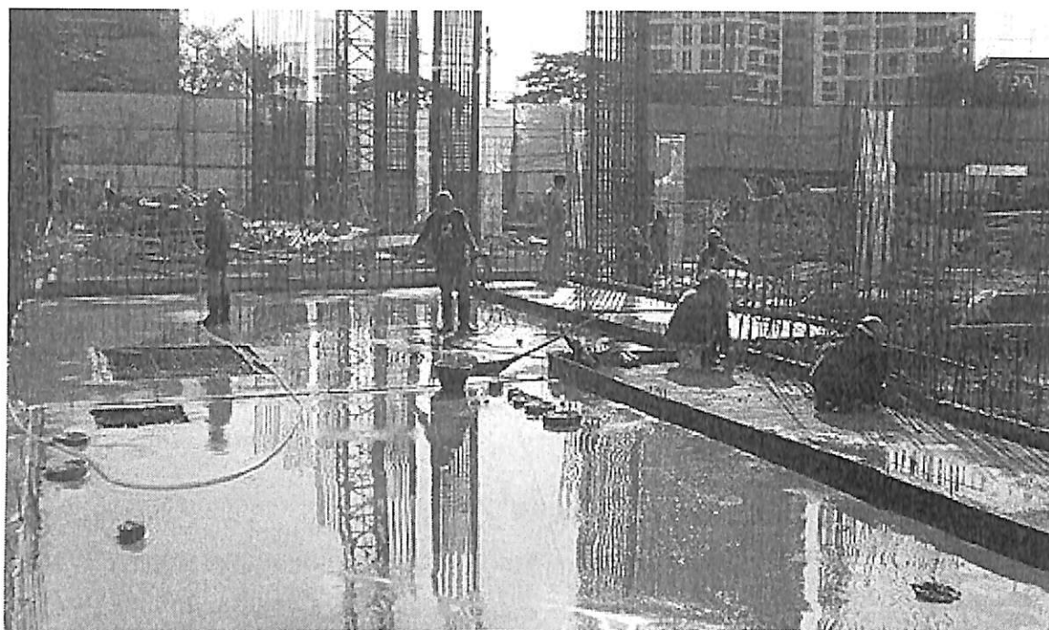
ภาพประกอบที่ 20 การบ่มคอนกรีต บ่มเปียก
