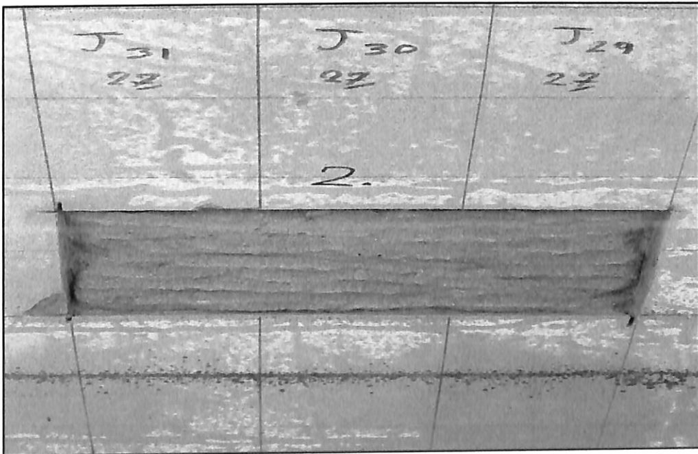
ภาพประกอบที่ ก.6 พื้นที่ได้ทำความสะอาดเรียบร้อยแล้วเพื่อจะทำงานซ่อมรอยแตกร้าว
