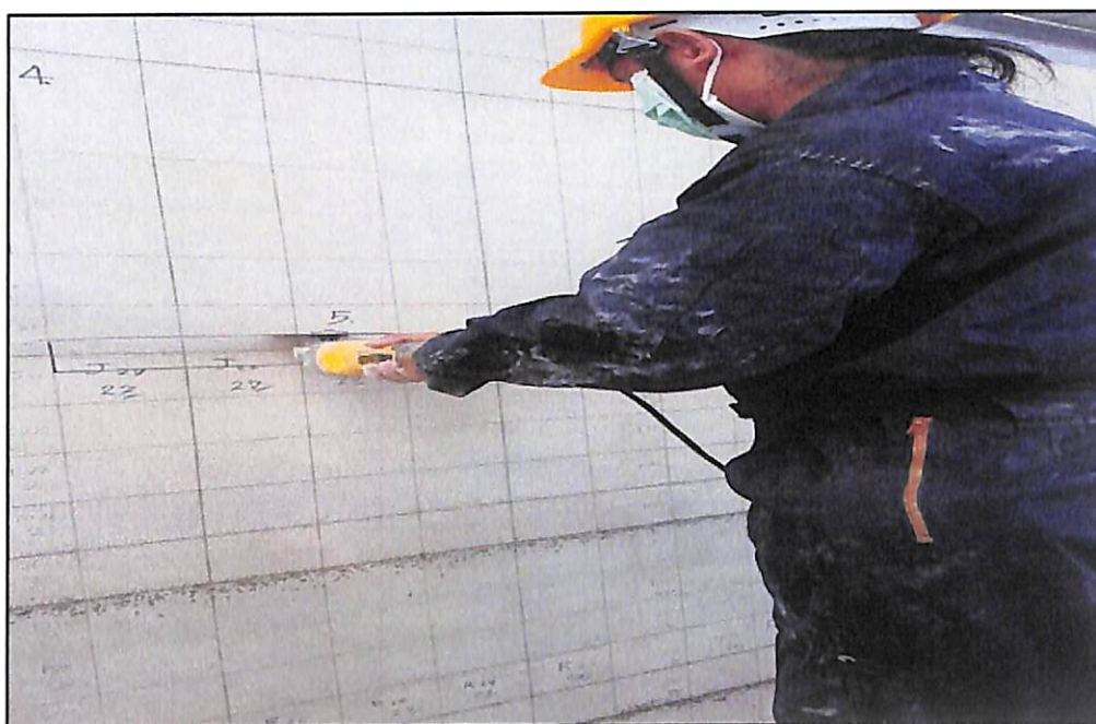
ภาพประกอบที่ ก.37 กริดผนังที่บริเวณที่จะซ่อมห่างจากรอยร้าวข้างละ 3 เซนติเมตร
