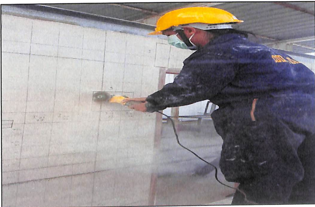
ภาพประกอบที่ ก.14 กรีดผนังที่บริเวณที่จะซ่อมห่างจากรอยร้าวข้างละ 3 เซนติเมตร
