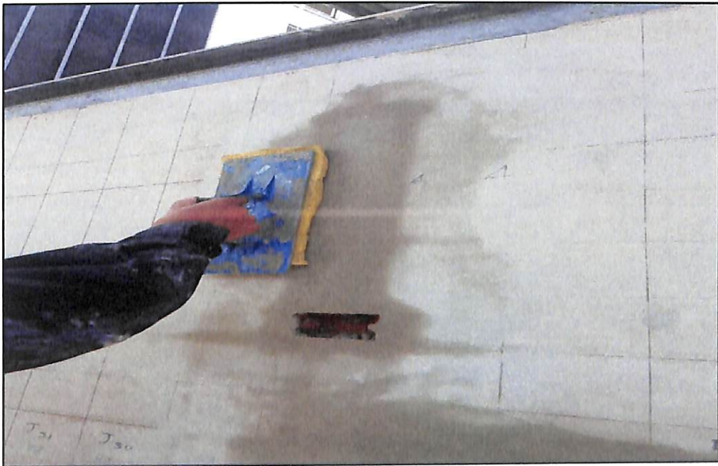
ภาพประกอบที่ ก.34 ปั่นลงฟองน้ำ เพื่อทำให้ผิวผนังปูนฉาบเรียบละเอียด
