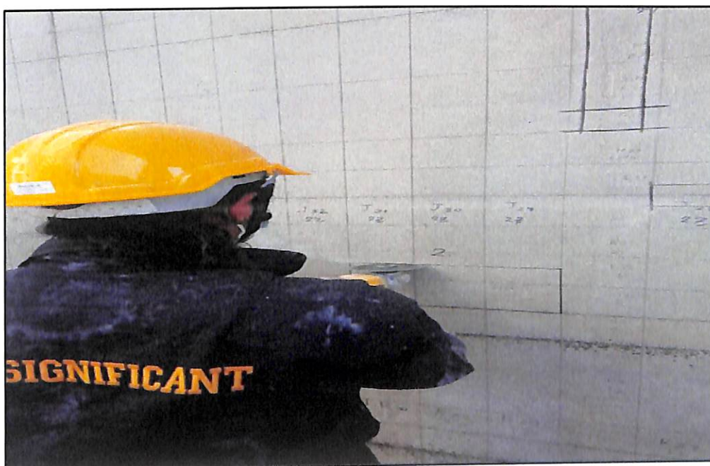
ภาพประกอบที่ ก.2 กรีดผนังที่บริเวณที่จะซ่อม โดยห่างจากรอยร้าวข้างละ 3 เซนติเมตร
