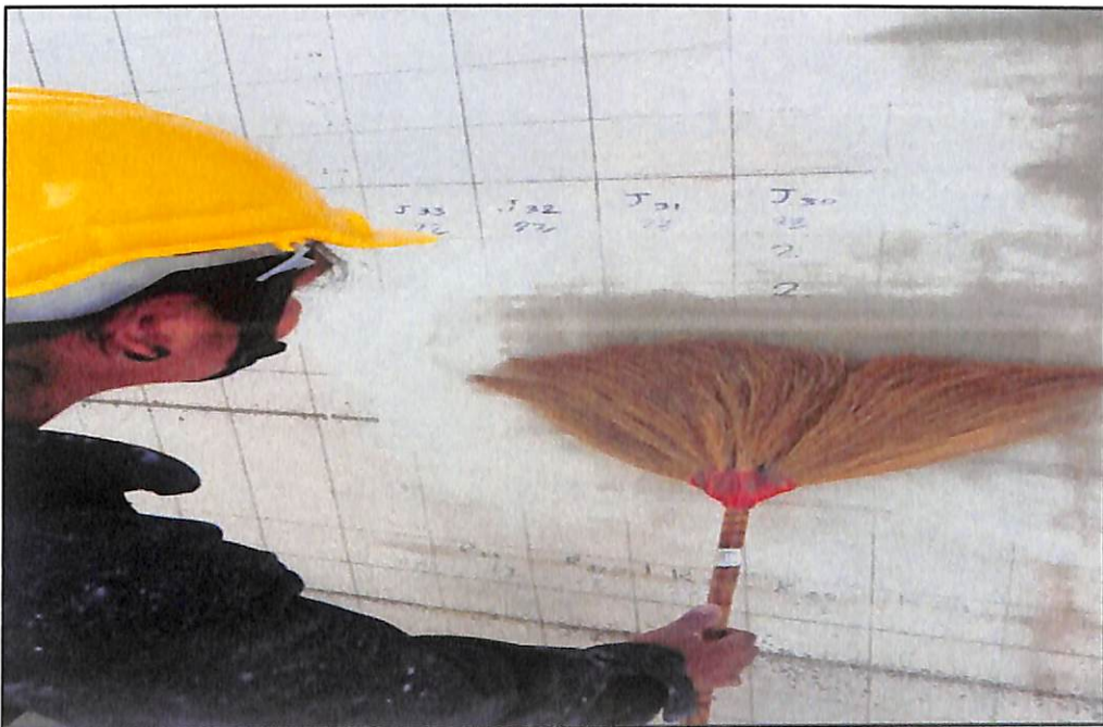
ภาพประกอบที่ ก.12 ปิดกวาดเศษเม็ดทรายบนผิวผนังบริเวณที่ซ่อม
