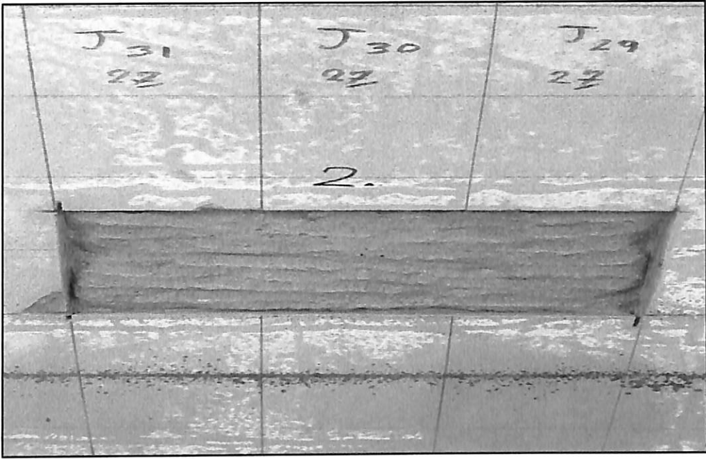
ภาพประกอบที่ ก.7 ใส่ปูนในพื้นที่ที่กำหนดรอยแตกแล้วให้เต็มพื้นที่
