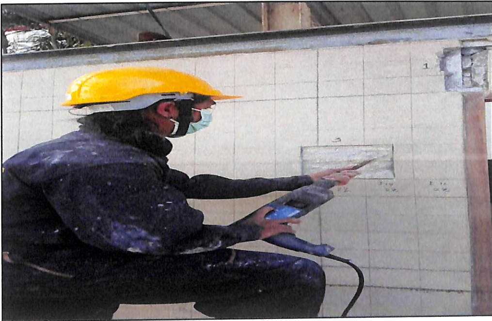
ภาพประกอบที่ ก.16 สก๊อตผนังปูนฉาบบริเวณที่กำหนดที่กริดผนังเรียบร้อยแล้ว
