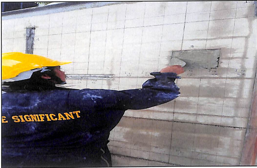
ภาพประกอบที่ ก.19 ไม้ปูนในพื้นที่ ที่กำหนดรอยแตกร้าวให้เต็มพื้นที่
