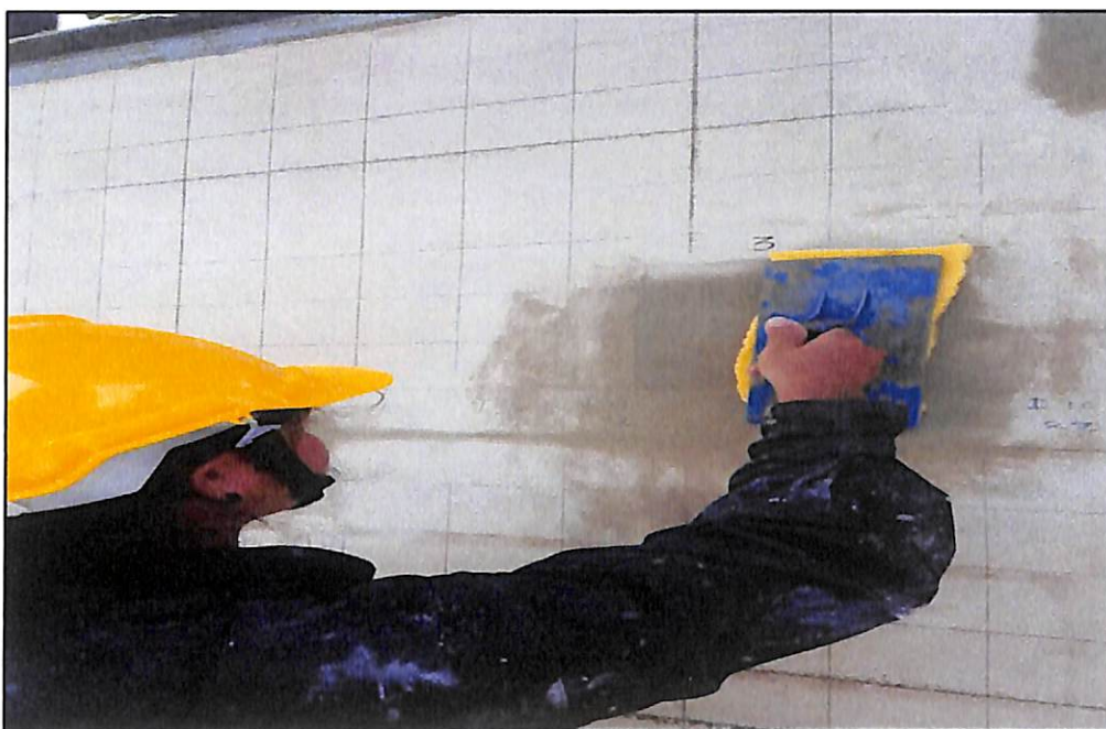
ภาพประกอบที่ ก.23 ปั่นลงฟองน้ำเพื่อทำให้ผิวผนังปูนฉาบเรียบละเอียด
