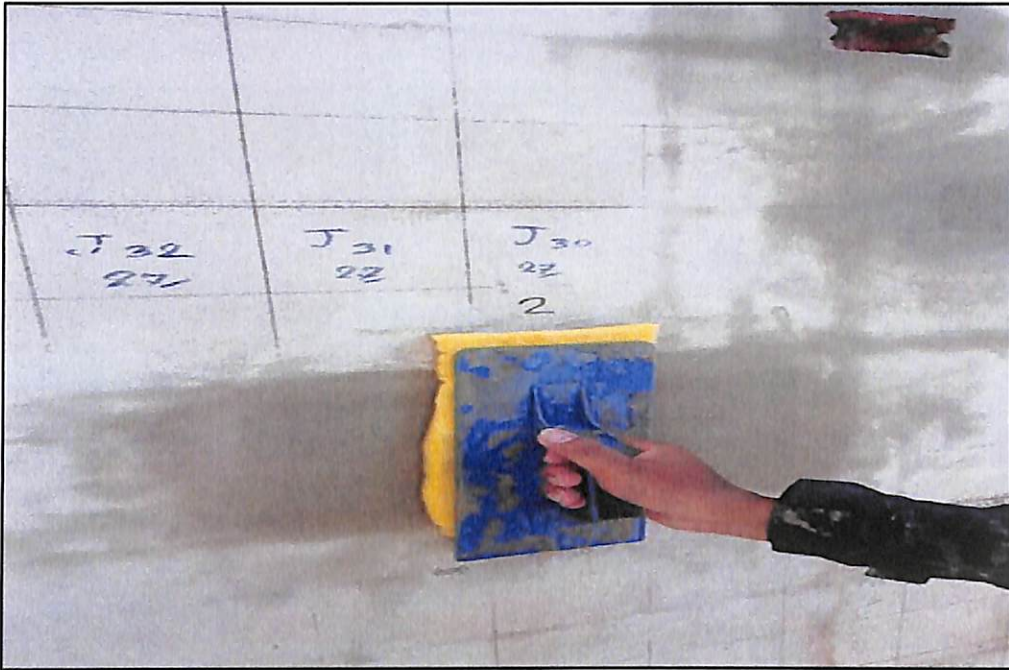
ภาพประกอบที่ ก.11 ปั้นลงฟองน้ำเพื่อทำให้ผิวผนังปูนฉาบเรียบละเอียด
