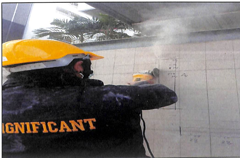
ภาพประกอบที่ ก.26 กรีดผนังที่บริเวณที่จะซ่อมห่างจากรอยร้าวข้างละ 3 เซนติเมตร
