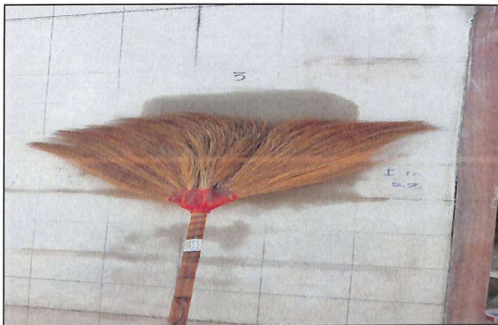
ภาพประกอบที่ ก.24 ปัดกวาดเศษเม็ดยาบนผิวผนังบริเวณที่ซ่อม
