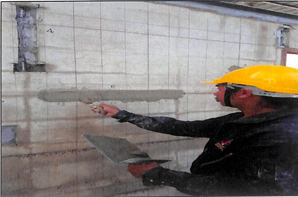
ภาพประกอบที่ ก.44 ใส่ปูนปิดตาข่ายไฟเบอร์ให้เต็มพื้นที่
