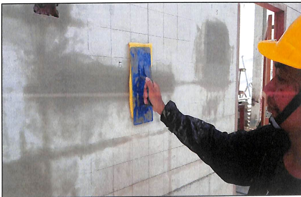
ภาพประกอบที่ ก.46 ปั่นลงฟองน้ำ เพื่อทำให้ผิวผนังปูนฉาบเรียบละเอียด
