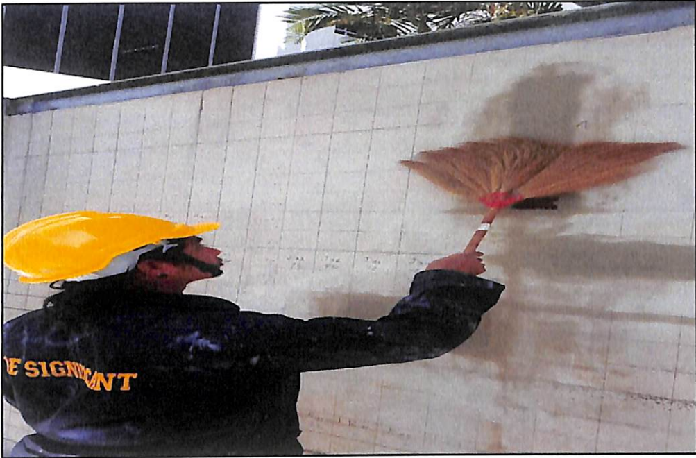
ภาพประกอบที่ ก.35 บัดควาดเศษเม็ดทรายบนผิวผนังบริเวณที่ซ่อม
