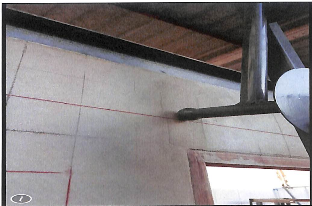
ภาพประกอบที่ ค.7 ลูกตุ้มหนัก 3 กิโลกรัมกระแทกผนังจุดที่กำหนดไว้
