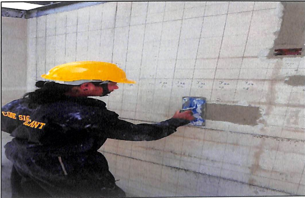
ภาพประกอบที่ ก.10 ทิ้งไว้ให้ปูนหมาดๆ ปั่นหน้าปูนด้วยเกรียงเพื่อทำให้ปูนเกิดผิวที่แข็งแรง
