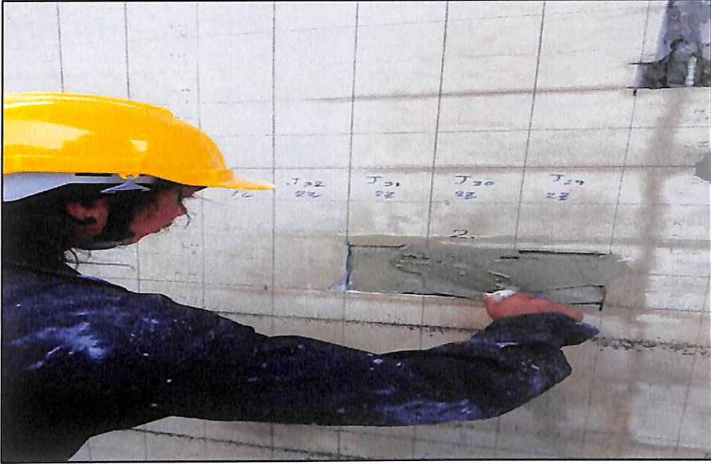
ภาพประกอบที่ ก.9 ใส่ปูนปิดตาข่ายไฟเบอร์ให้เต็มพื้นที่
