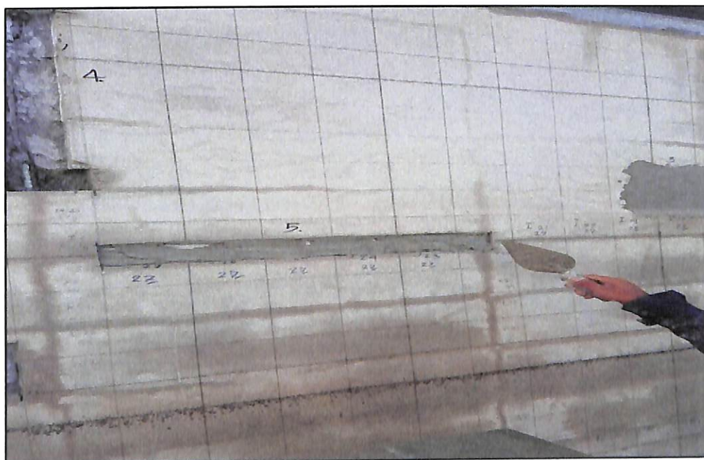
ภาพประกอบที่ ก.42 ใส่ปูนในพื้นที่ที่กำหนดรอยแตกร้าวให้เต็มพื้นที่
