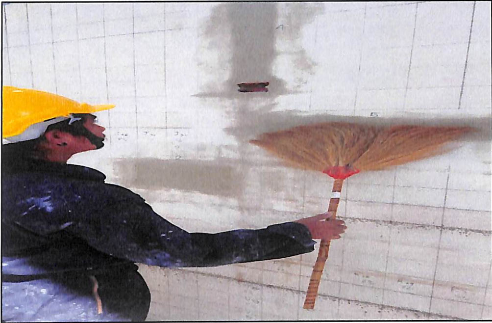
ภาพประกอบที่ ก.47 ปัดกวาดเศษเม็ดทรายบนผิวผนังบริเวณที่ซ่อม
