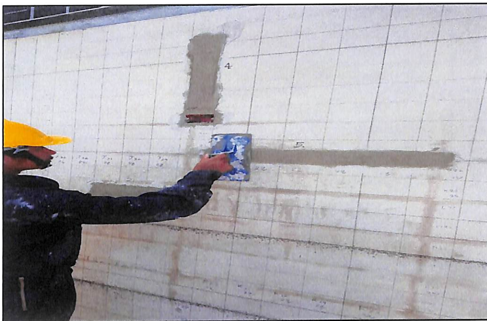
ภาพประกอบที่ ก.45 ทิ้งไว้ให้ปูนหมาดๆ ปั่นหน้าปูนด้วยเกรียงเพื่อทำให้ปูนเกิดผิวที่แข็งแรง
