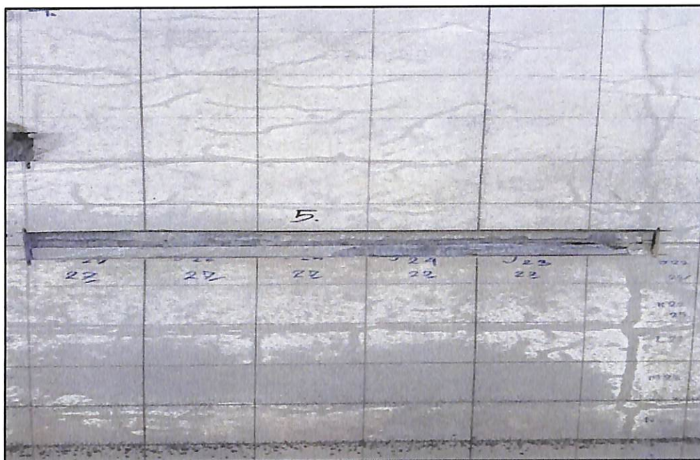
ภาพประกอบที่ ก.41 พื้นที่ได้ทำความสะอาดเรียบร้อยแล้วเพื่อจะทำงานซ่อมรอยแตกร้าว
