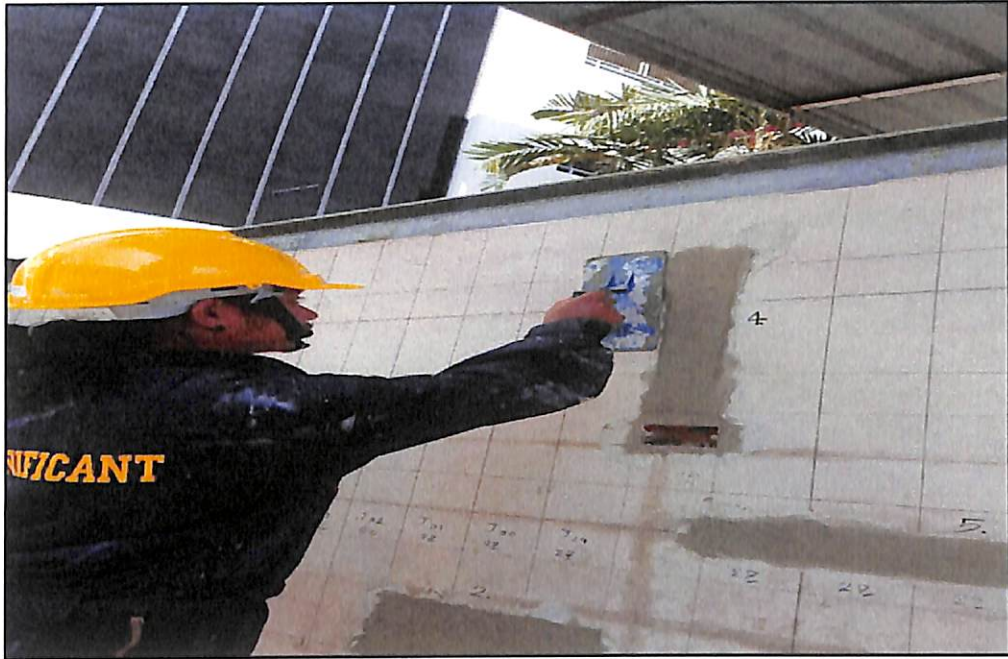
ภาพประกอบที่ ก.33 ทิ้งไว้ให้ปูนหมาดๆบนหน้าปูนด้วยเกรียงเพื่อทำให้ปูนเกิดผิวที่แข็งแรง
