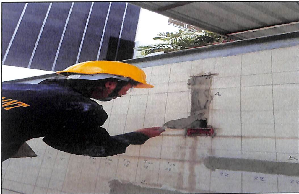
ภาพประกอบที่ ก.30 ใส่ปูนในพื้นที่ ที่กำหนดรอยแตกไว้ให้เต็มพื้นที่
