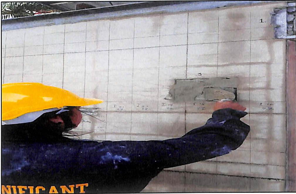
ภาพประกอบที่ ก.21 ใส่ปูนปิดตาข่ายไฟเบอร์ให้เต็มพื้นที่
