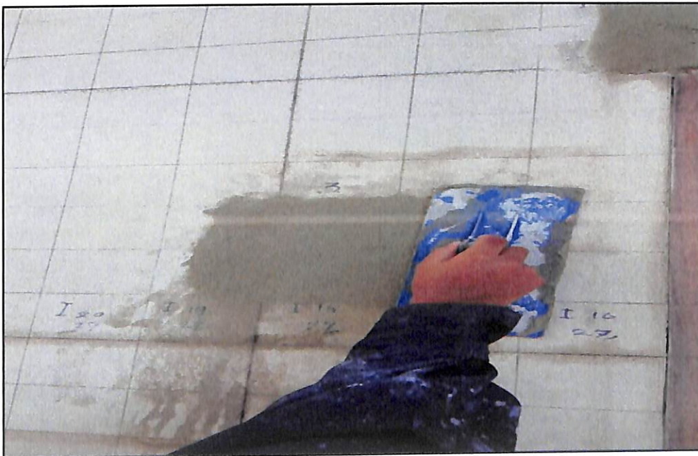
ภาพประกอบที่ ก.22 ทิ้งไว้ให้ปูนหมาด ๆ ปั่นหน้าปูนด้วยเกรียงเพื่อทำให้ปูนเกิดผิวที่แข็งแรง
