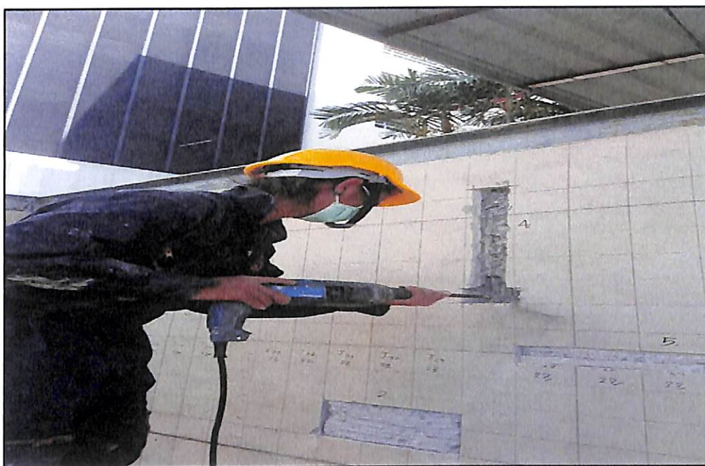
ภาพประกอบที่ ก.27 กรีดผนังบริเวณที่กำหนดที่จะซ่อมรอยแตกร้าว
