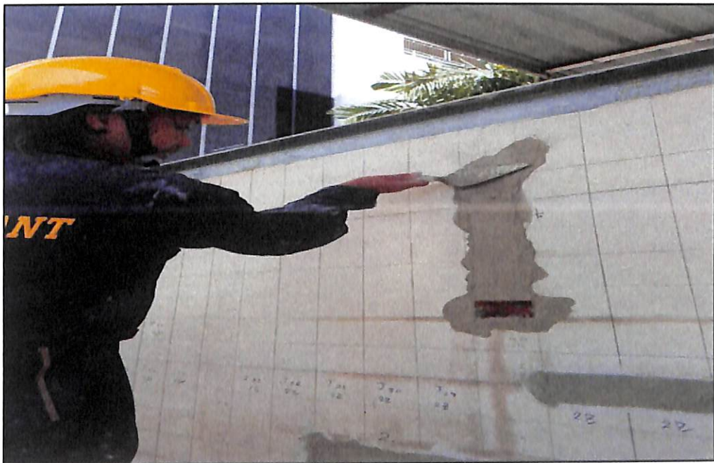
ภาพประกอบที่ ก.32 ใส่ปูนปิดดาข่ายไฟเบอร์ให้เต็มพื้นที่
