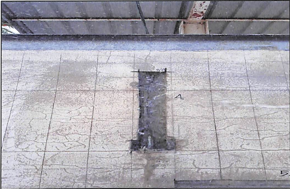
ภาพประกอบที่ ก.29 ฉีดน้ำล้างทำความสะอาดเศษฝุ่นต่าง ๆ บริเวณที่จะซ่อม
