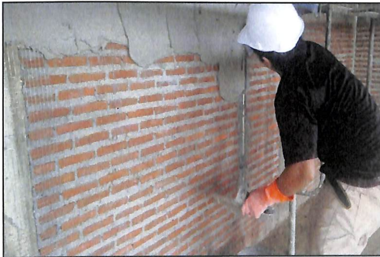
ภาพประกอบที่ 2.1 การฉาบปูนผนังก่ออิฐ
