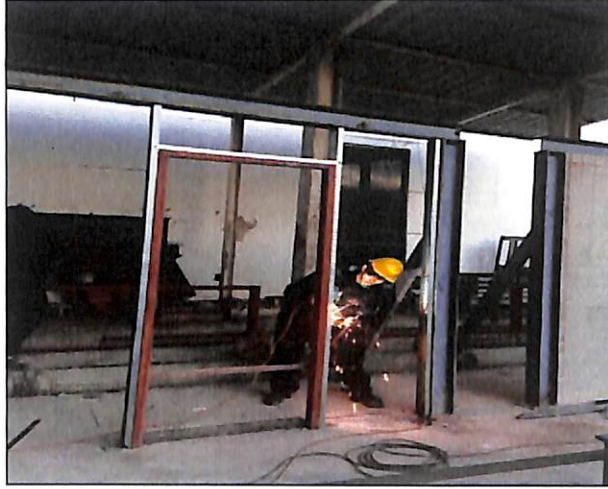
ภาพประกอบที่ 3.4 การติดตั้งวงกบประตู
