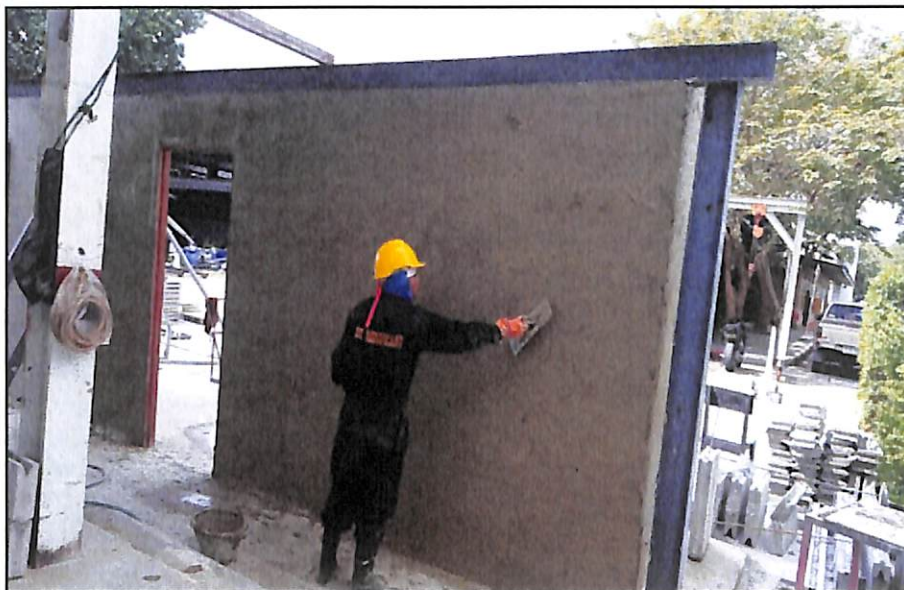
ภาพประกอบที่ 3.12 ขั้นตอนที่ 4 ใช้เกรียงไม้เติมเนื้อปูนในส่วนที่ยังพร่องให้ผนังผิวหน้าได้ระดับ
