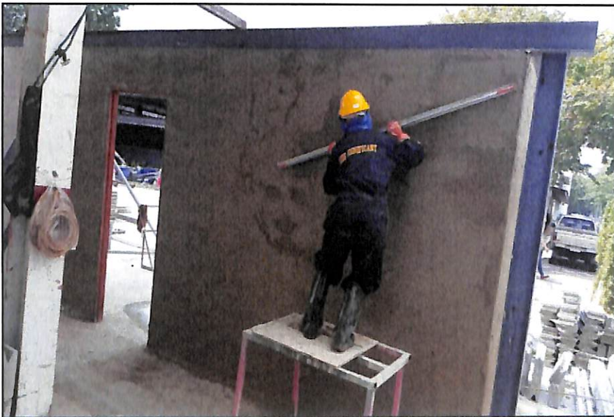
ภาพประกอบที่ 3.11 ขั้นตอนที่ 3 ใช้สามเหลี่ยมปาดปูนและเชือกเนื้อปูนที่ล้นเกินจากระดับที่จับเชือกไว้
