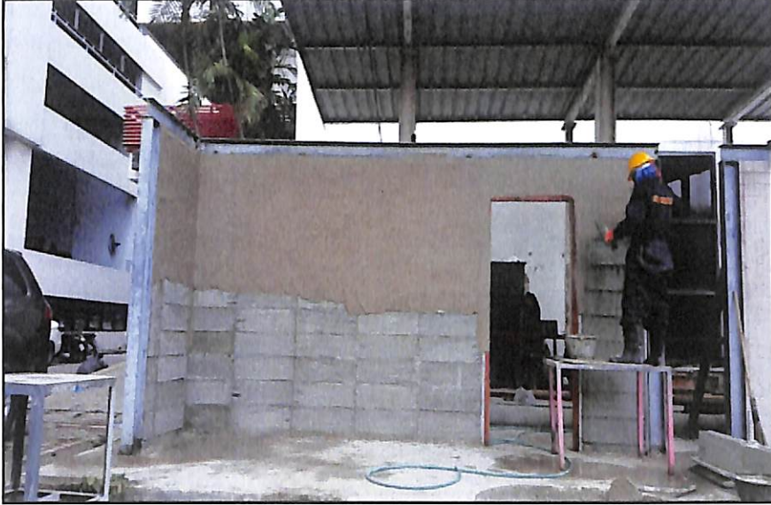
ภาพประกอบที่ 3.10 ขั้นตอนที่ 2 ฉาบปูนทันทีหลังจากราดน้ำ โดยขึ้นจากด้านบนลงด้านล่าง ให้เต็มพื้นที่
