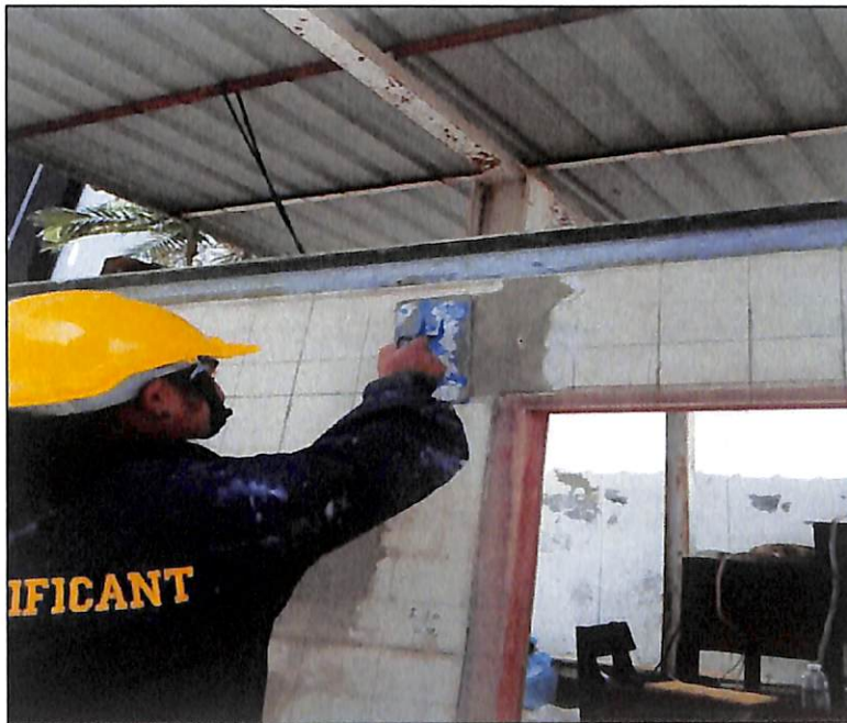
ภาพประกอบที่ 4.14 ทิ้งไว้ให้ปูนหมาด ๆ ปั่นหน้าปูนด้วยเกรียงเพื่อทำให้ปูนเกิดผิวที่แข็งแรง
