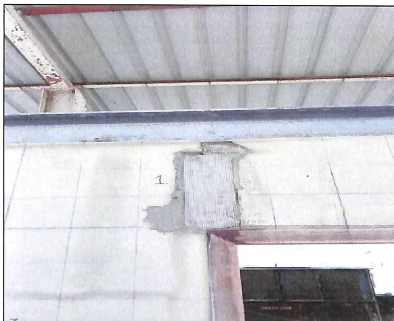
ภาพประกอบที่ 4.12 ใส่ตาข่ายไฟเบอร์บริเวณที่กำหนดเนื้อวงกบขอบประตู
