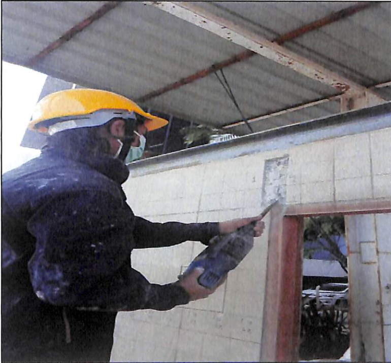
ภาพประกอบที่ 4.8 สก๊อตผนังปูนฉาบบริเวณที่กำหนดเหนือขอบวงกบที่กริดผนังเรียบร้อยแล้ว
