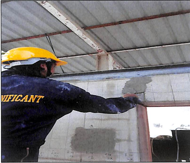
ภาพประกอบที่ 4.13 ใส่ปูนปิดตาข่ายไฟเบอร์ให้เต็มพื้นที่
