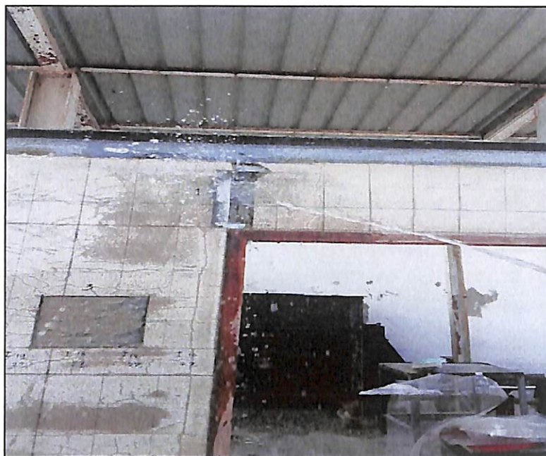
ภาพประกอบที่ 4.9 ฉีดน้ำล้างทำความสะอาดเศษฝุ่นต่าง ๆ บริเวณที่จะซ่อม
