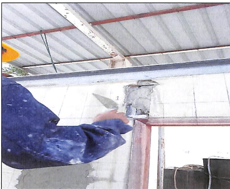
ภาพประกอบที่ 4.11 ใส่ปูนในพื้นที่ ที่กำหนดรอยแตกกร้าวเนื้อวงกบให้เต็มพื้นที่
