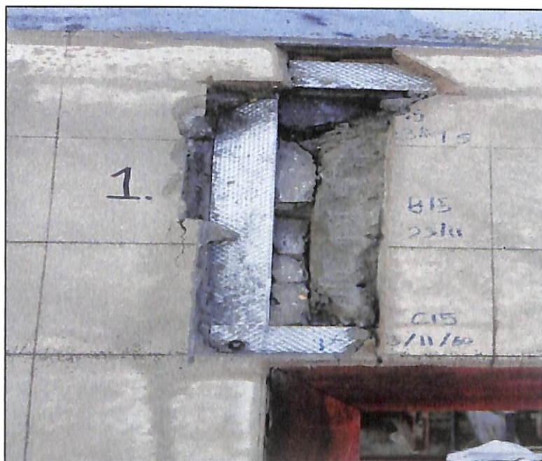
ภาพประกอบที่ 4.10 พื้นที่ได้ทำความสะอาดเรียบร้อยแล้วเพื่อจะทำงานซ่อมรอยแตกกร้าวเนื้อวงกบประตู
