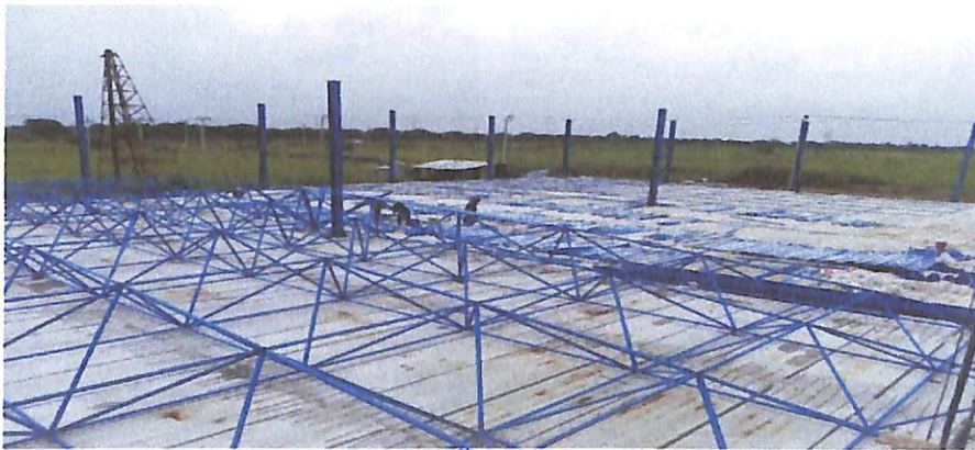
ภาพประกอบที่ 2.14 การประกอบชิ้นส่วน 2 ใน (Space Rigid Frame)
