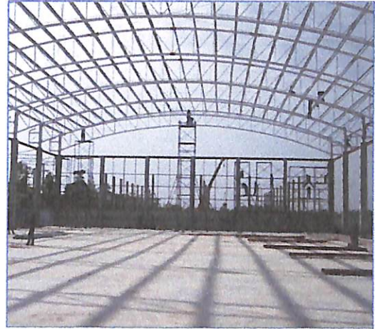
ภาพประกอบที่ 2.3 แบบขยาย T1 โครงสร้างหลังคาแบบ (Steel Truss)
