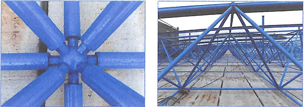
ภาพประกอบที่ 2.7 (ต่อ) แบบแสดงชิ้นส่วนที่เป็น (Bolted Sphere Node ใน Space Rigid Frame) ที่มา : บริษัท พรีเม้าโกลบอลลิงค์ จำกัด
