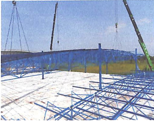
ภาพประกอบที่ 2.17 การยกโครง (Space Rigid Frame) ขึ้นติดตั้งบนหัวเสา
