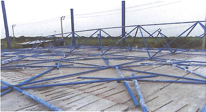
ภาพประกอบที่ 2.13 การประกอบชิ้นส่วน 1 ใน (Space Rigid Frame)
