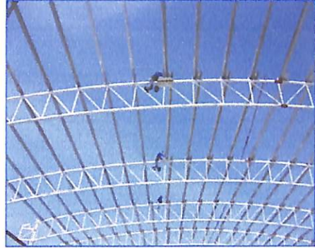
ภาพประกอบที่ 2.5 แบบแปล โครงสร้างหลังคาแบบ (Steel Truss) ที่มา : บริษัท พรอสเพค ดีเวลลอปเม้นท์ จำกัด
