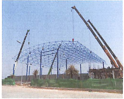
ภาพประกอบที่ 2.17 การยกโครง (Space Rigid Frame) ขึ้นติดตั้งบนหัวเสา
