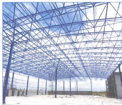
ภาพประกอบที่ 2.6 แบบแสดงชิ้นส่วนที่เป็น (Member ใน Space Rigid Frame)
