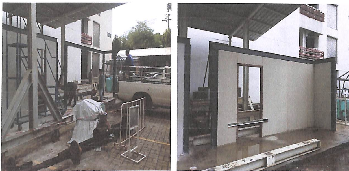
ภาพประกอบที่ 4.1 ผนังทดสอบระบบผนังหล่ออินฟิวลัด
