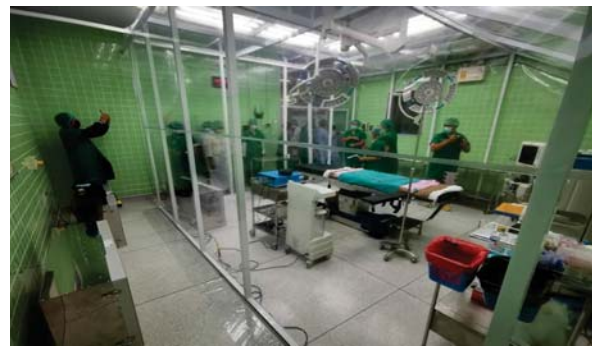
รูปที่ 8 Negative Chamber ในห้องผ่าตัดฉุกเฉิน ณ โรงพยาบาลสายบุรี จังหวัดปัตตานี
