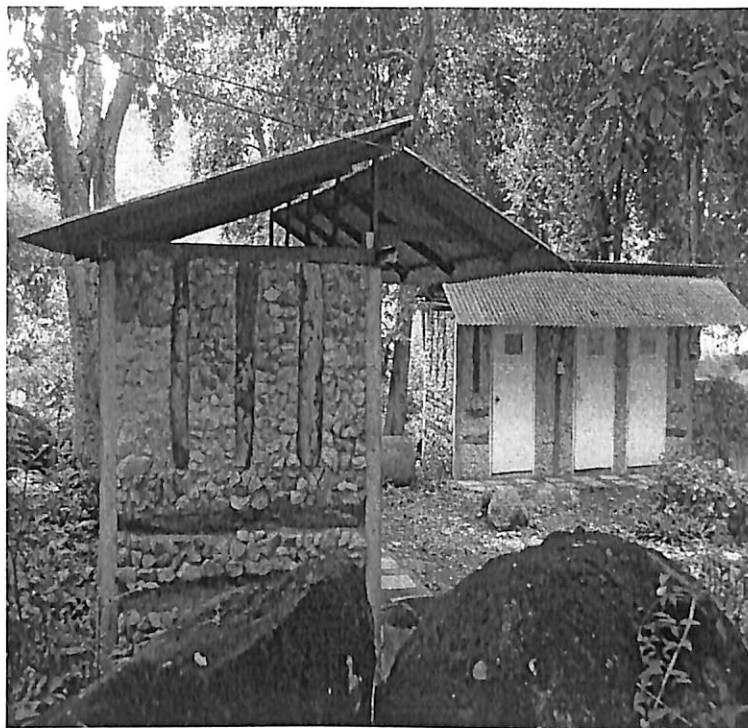
ภาพที่ 4.4 สภาพห้องน้ำที่อยู่ภายในบริเวณอ่างเก็บน้ำเขาสามลิบ
