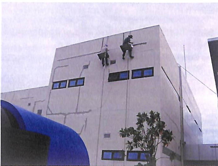
ภาพประกอบที่ 1.1 ปัญหาผนังอาคารก่ออิฐ-ฉาบปูนแตกร้าวเป็นลายงา
