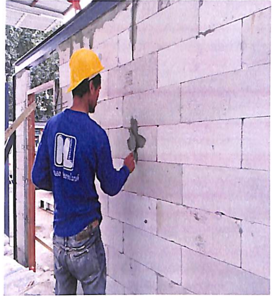
ภาพประกอบที่ 4.4 ผนังทดสอบระบบผนังก่ออิฐมวลเบา
