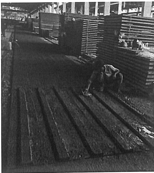
ภาพแสดงการใช้เกรียงฉาบผิวคอนกรีตแผ่นพื้นสำเร็จรูปที่หงายให้เรียบ
