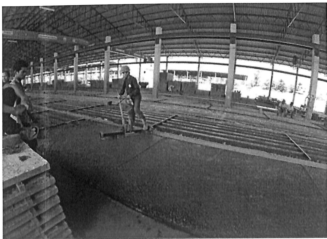
ภาพแสดงการใช้เครื่องจักรคอนกรีตให้แน่น
