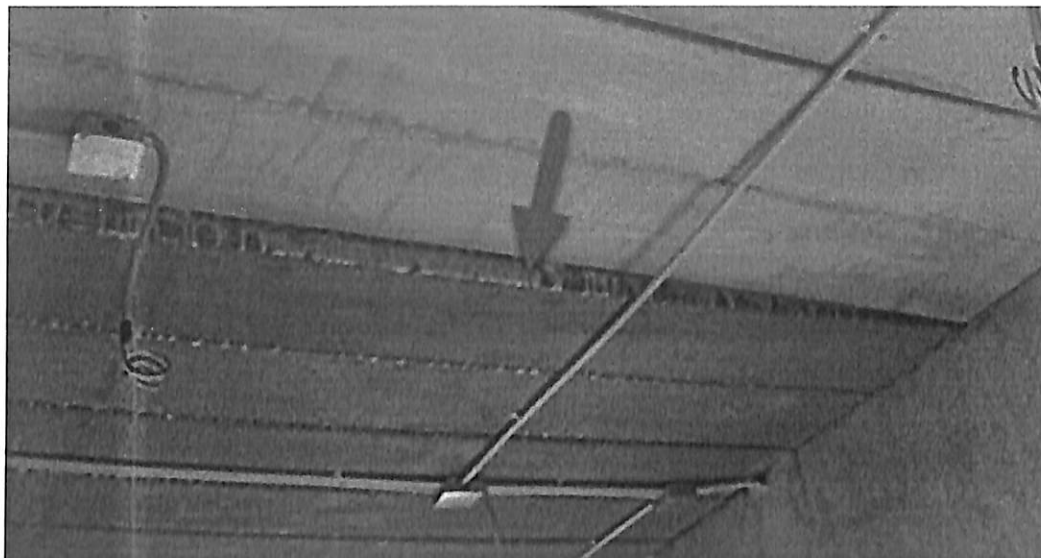
ภาพประกอบที่ 1.1 ปัญหาการติดตั้งแผ่นพื้นสำเร็จรูปท้องพื้นไม่สม่ำเสมอ (Sfscisky, 2558)
