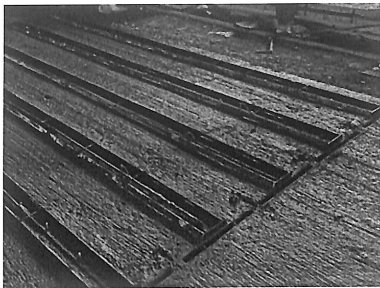
ภาพประกอบที่ 3.5 แสดงการเสริมเหล็กและการเข้าแบบแผ่นพื้นสำเร็จรูปที่หางย
