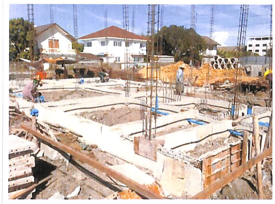
ภาพประกอบที่ 3.5 งานคานชั้นที่ 1
