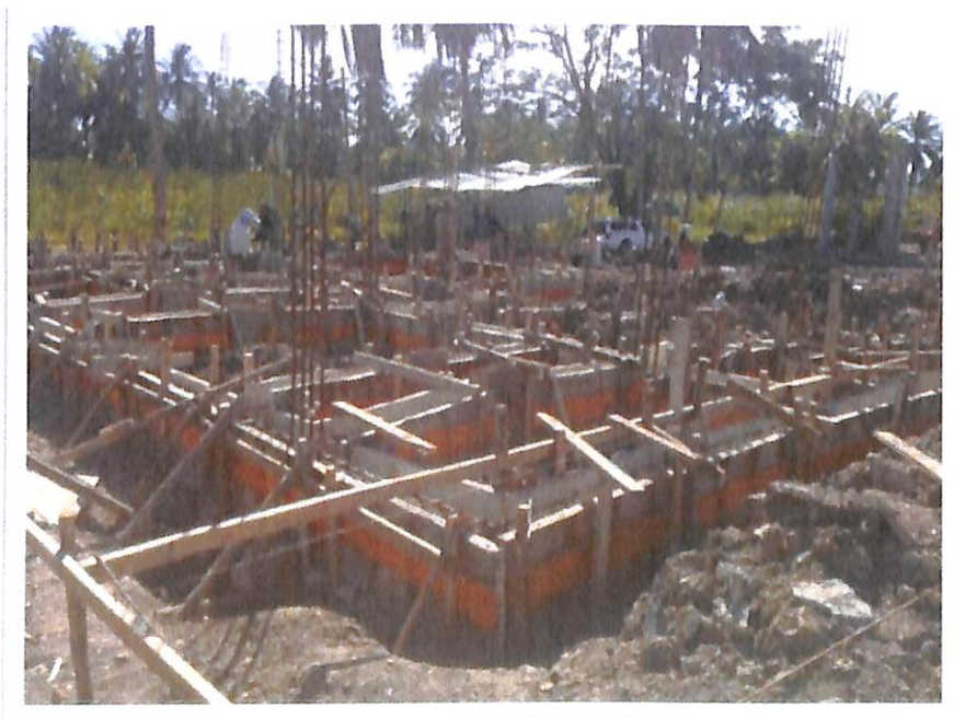
ภาพประกอบที่ 3.4 งานคานชั้นที่ 1
