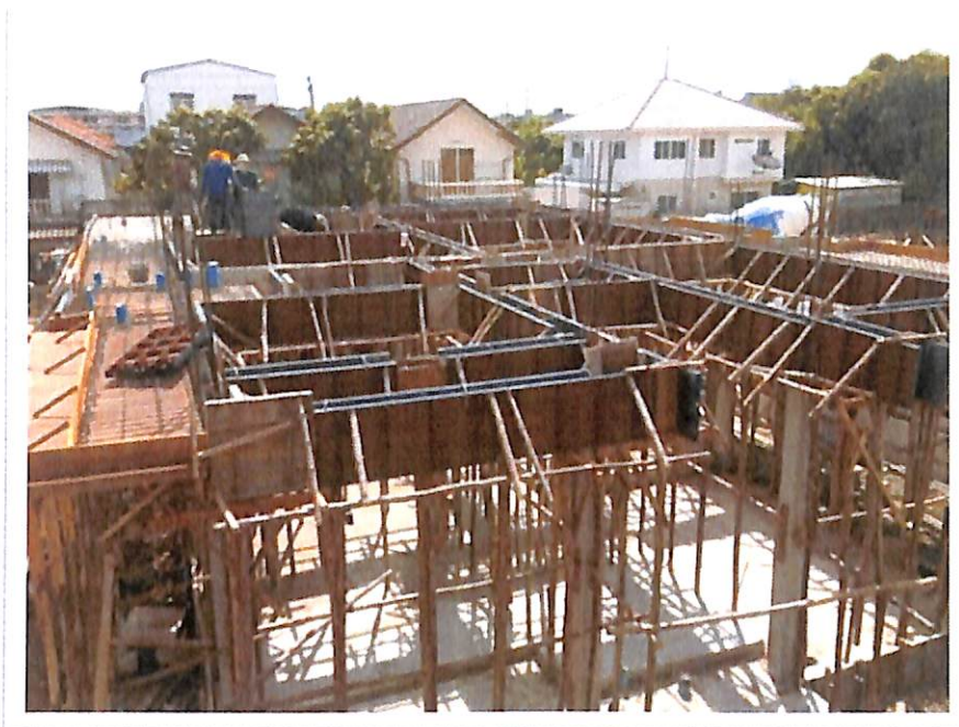
ภาพประกอบที่ 3.7 งานคานชั้นที่ 2
