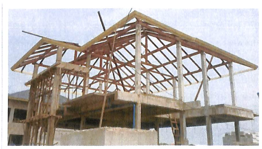
ภาพประกอบที่ 3.8 งานโครงหลังคา
