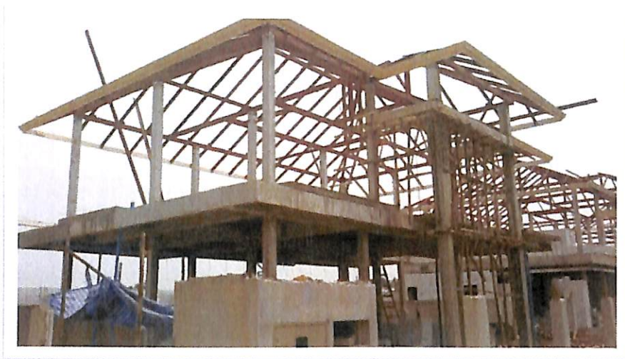
ภาพประกอบที่ 3.9 งาน โครงหลังคา
