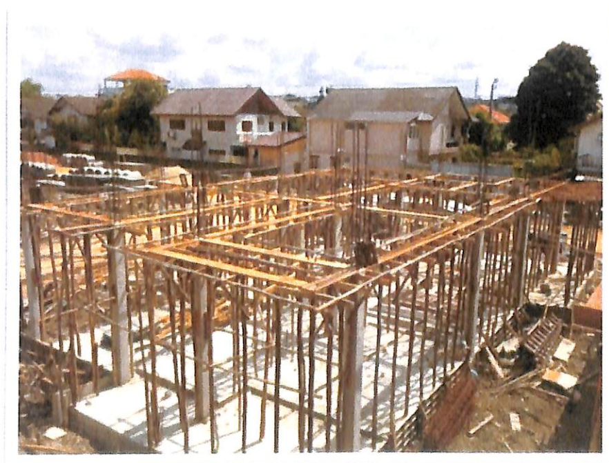
ภาพประกอบที่ 3.6 งานคานชั้นที่ 2
