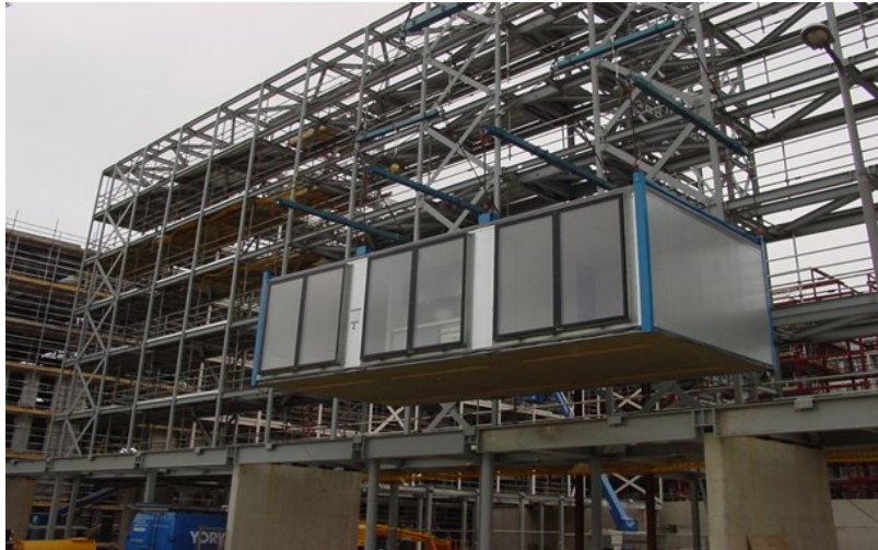
ภาพที่ 26 ตัวอย่างการประกอบให้เป็นตัวตึกโดยใช้วิธีการก่อสร้างสำเร็จรูป
