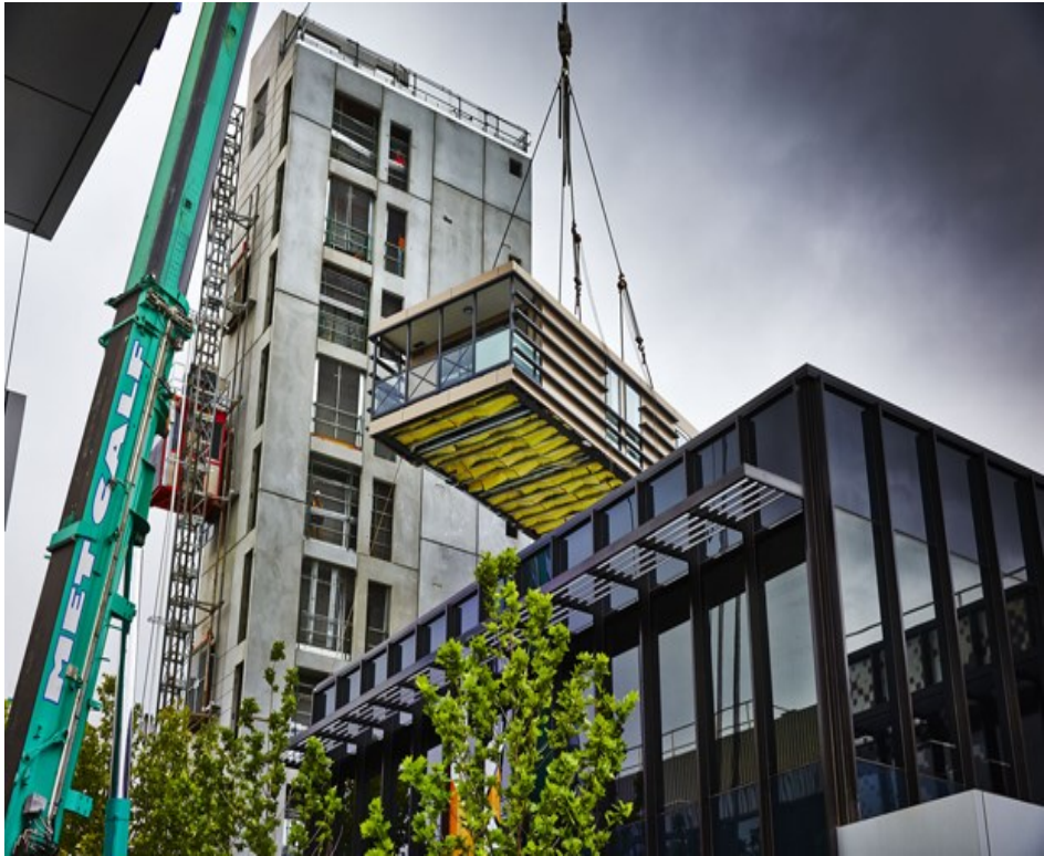
ภาพที่ 23 ตัวอย่างการประกอบให้เป็นตัวตึกโดยใช้วิธีการก่อสร้างสำเร็จรูป
