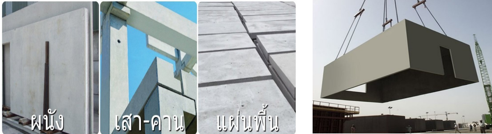
ภาพที่ 27 ตัวอย่างการประกอบให้เป็นตัวตึกโดยใช้วิธีการก่อสร้างสำเร็จรูป
