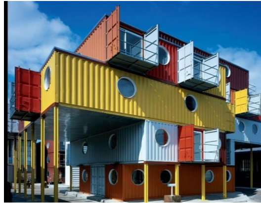
ภาพที่ 24 ตัวอย่างการประกอบให้เป็นตัวตึกโดยใช้วิธีการก่อสร้างสำเร็จรูป
