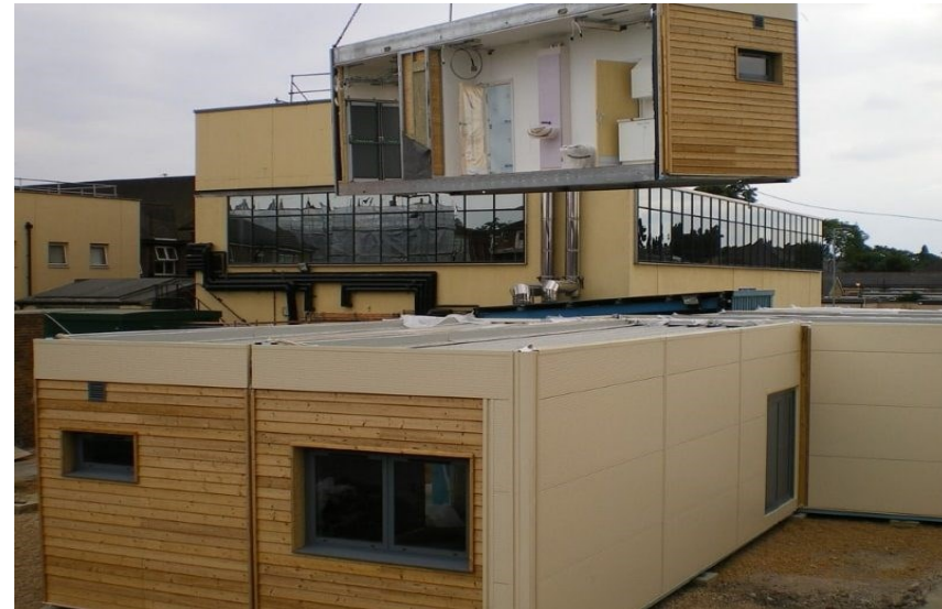
ภาพที่ 25 ตัวอย่างการประกอบให้เป็นตัวตึกโดยใช้วิธีการก่อสร้างสำเร็จรูป
