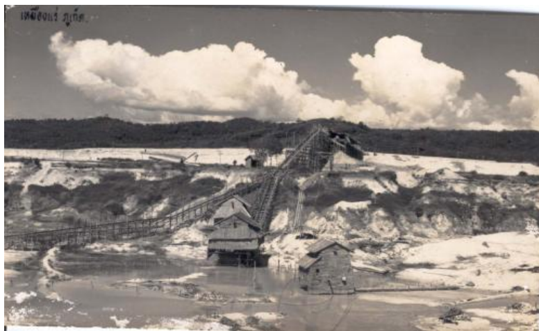
รูปที่ 11 รูปแบบเหมืองฉีด
