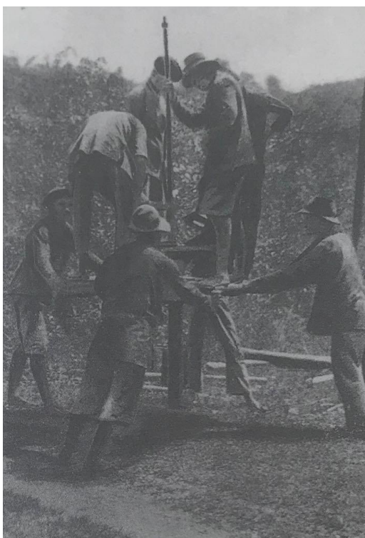
รูปที่ 19 การเจาะสำรวจแร่
