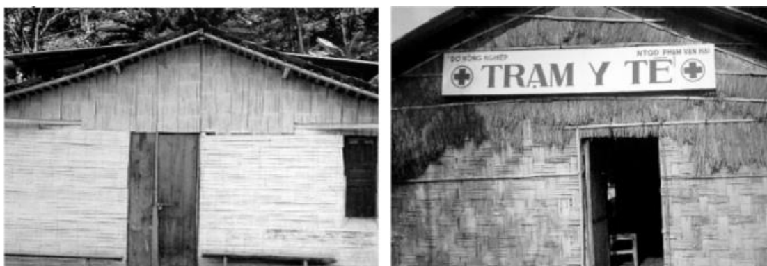
ภาพที่ 20 แสดงลักษณะของผนังไม้ไผ่ในรูปแบบการสาน
