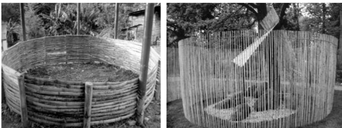
ภาพที่ 22 แสดงลักษณะของผนังไม้ไผ่ในรูปแบบทั้งลำ
