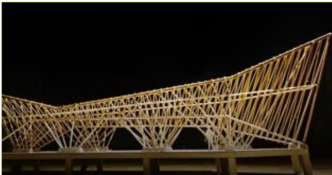
ภาพที่ 31 แสดงลักษณะโครงสร้างแบบเสาแฉ่
