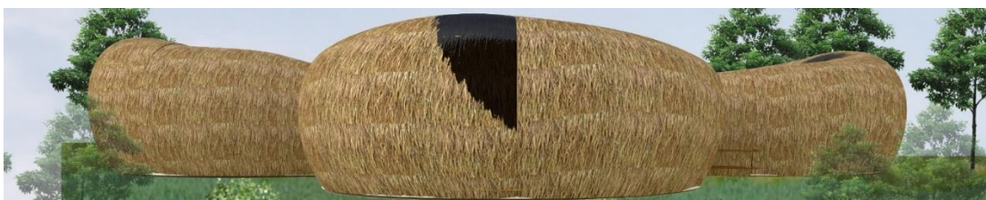
ภาพที่107 แสดงรูปด้านที่3 อาคารที่พักรวม
