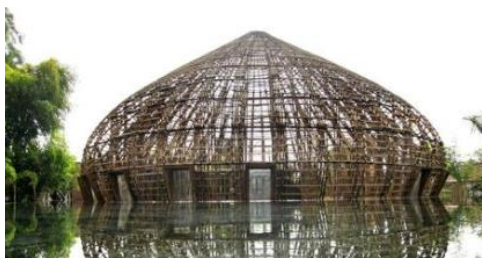
ภาพที่ 2.20 ลักษณะโครงสร้างแบบโดม
