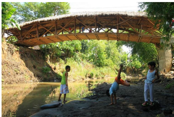
ภาพที่ 2.28 สะพาน Matina Bridge
