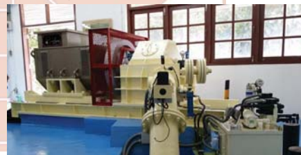
รูปที่ 1 เครื่องกังหันพลังงานน้ำชนิดเทอร์โก ของโรงไฟฟ้าพลังน้ำขนาดเล็กมากบ้านขุนแปะหลังปรับปรุง
