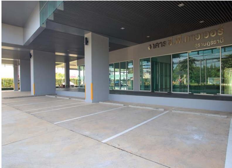
ภาพที่1 ส่วนด้านนอกของอาคาร ด้านหน้าจะเป็นที่จอดรถ
