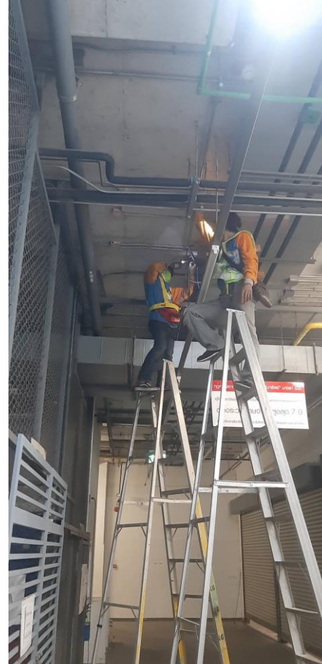
สรุป : เดินท่อเหล็ก EMT ร้อยสาย Fiber
